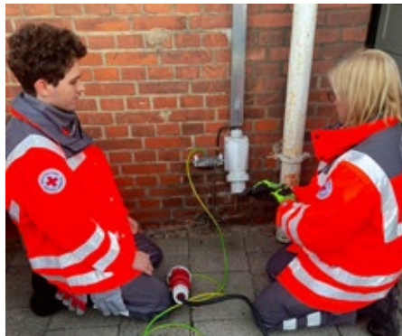
Falls der Strom ausfällt, helfen die Notvorrangschaltung (oben) und das Stromaggregat.
