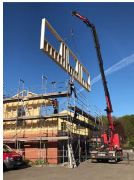
2018: Aufstockung zum neuen Bürogebäude
