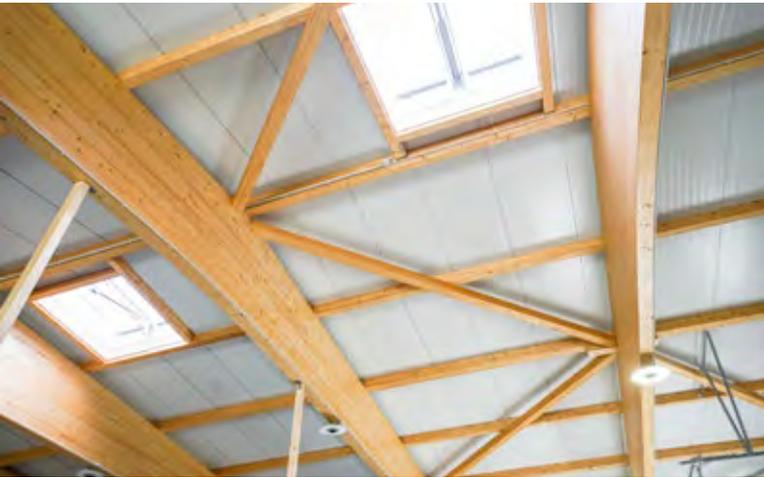
ist die Dachkonstruktion mit sogenannten Brett-schichtholzträgern. „Die überspannen eine Länge von 30 Metern“, verkündet Schwarzat stolz.
