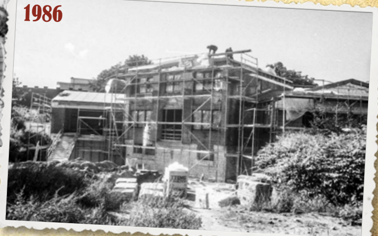
Neubau Betriebsgebäude der Versorgungsbetriebe Kronshagen GmbH in der Kopperpähler Allee 7.
