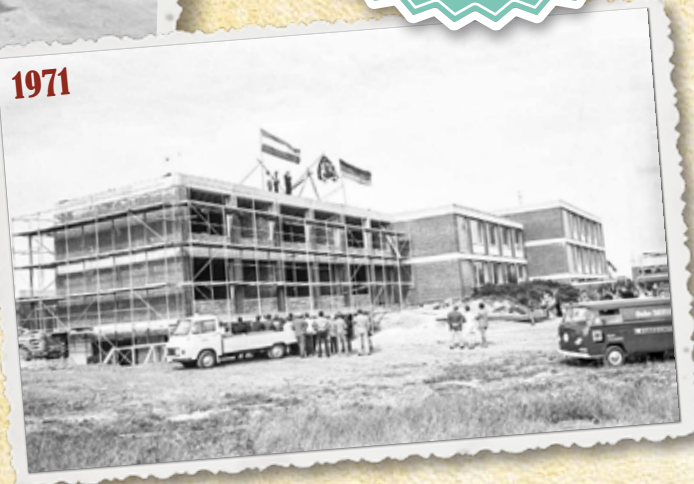
Richtfest beim Erweiterungsbau der Eichendorffschule am Suchsdorfer Weg 33-35.
