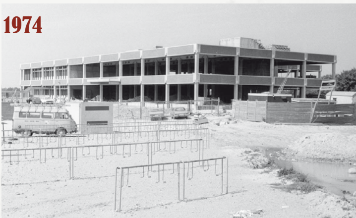
Neubau des Gymnasiums im Suchsdorfer Weg 35.
