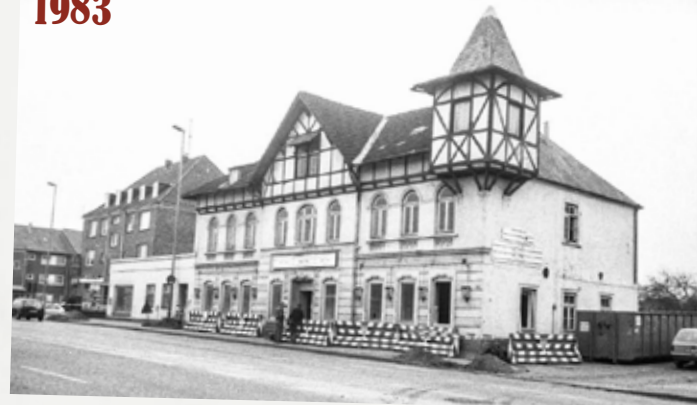
Nach der Verbreiterung der Eckernförder Straße wurde die Gaststätte Waidmannsruh 1983 abgerissen. Jahrzehntlang war ihr großer Saal gesellschaftliches Zentrum in Kronshagen.
