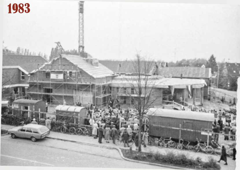
Richtfest beim Neubau des Bürgerhauses Kronshagen in der Kopperpähler Allee 69.
