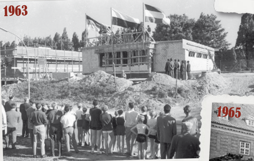
Richtfest beim Neubau des Vereinsjugendheims vom TSV Kronshagen im Eichkoppelweg 24.
